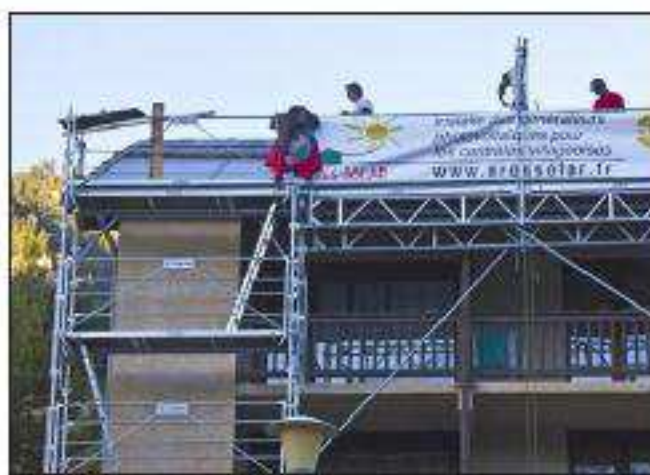
L'installation des générateurs photovoltaïques a été réalisée sur les toitures du Thioure, à Ceillac. Photo La D.U.M.
