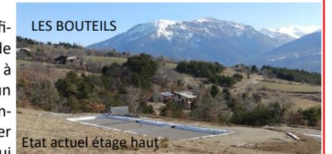
Les deux étages ont été creusés et une partie des éléments composant la station ont été posés. Les travaux redémarreront au printemps : relier la canalisation d'arrivée au réseau (chemin de Mounet), amener l'eau jusqu'à la station, terminer les deux étages et poser la canalisation de sortie des eaux traitées (travail délicat au regard du terrain, amener ces eaux jusqu'au torrent par une conduite posée en forte dénivellation).
