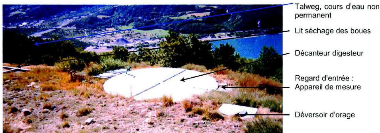
Les boues extraites du décanteur-digesteur sont dans un premier temps séchées (lit de séchage à proximité de la station d'épuration) puis épandues en terrain agricole.
