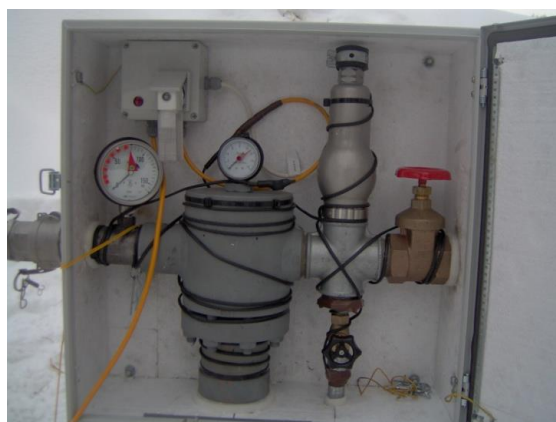
Limiteur de pression développé par Serre Chevallier-Vallée en collaboration avec le SDIS 05
