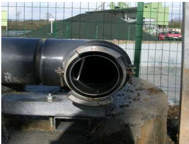
Une sortie de 100 mm avec les tenons verticaux (l'un au dessus de l'autre)
