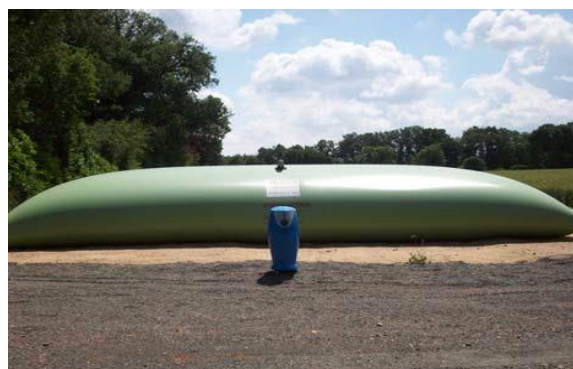
Réserve d'eau souple de 120 m 3 utilisable par le biais d'un poteau d'aspiration
