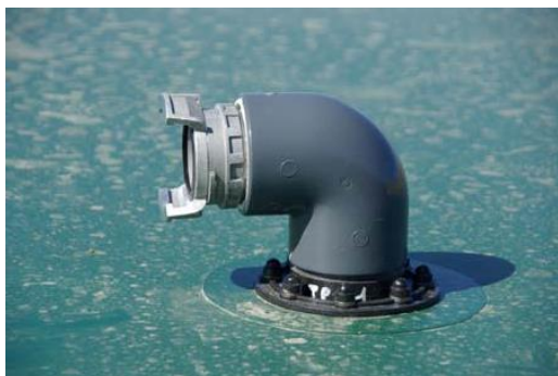
Orifice de remplissage
