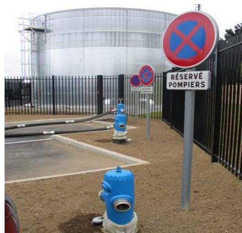
Réserve d'eau incendie aérienne de 720 m 3 équipée de 3 poteaux d'aspiration de 150 mm
