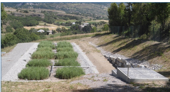
Les eaux usées seront filtrées par les roseaux comme ici à Saint-André.
